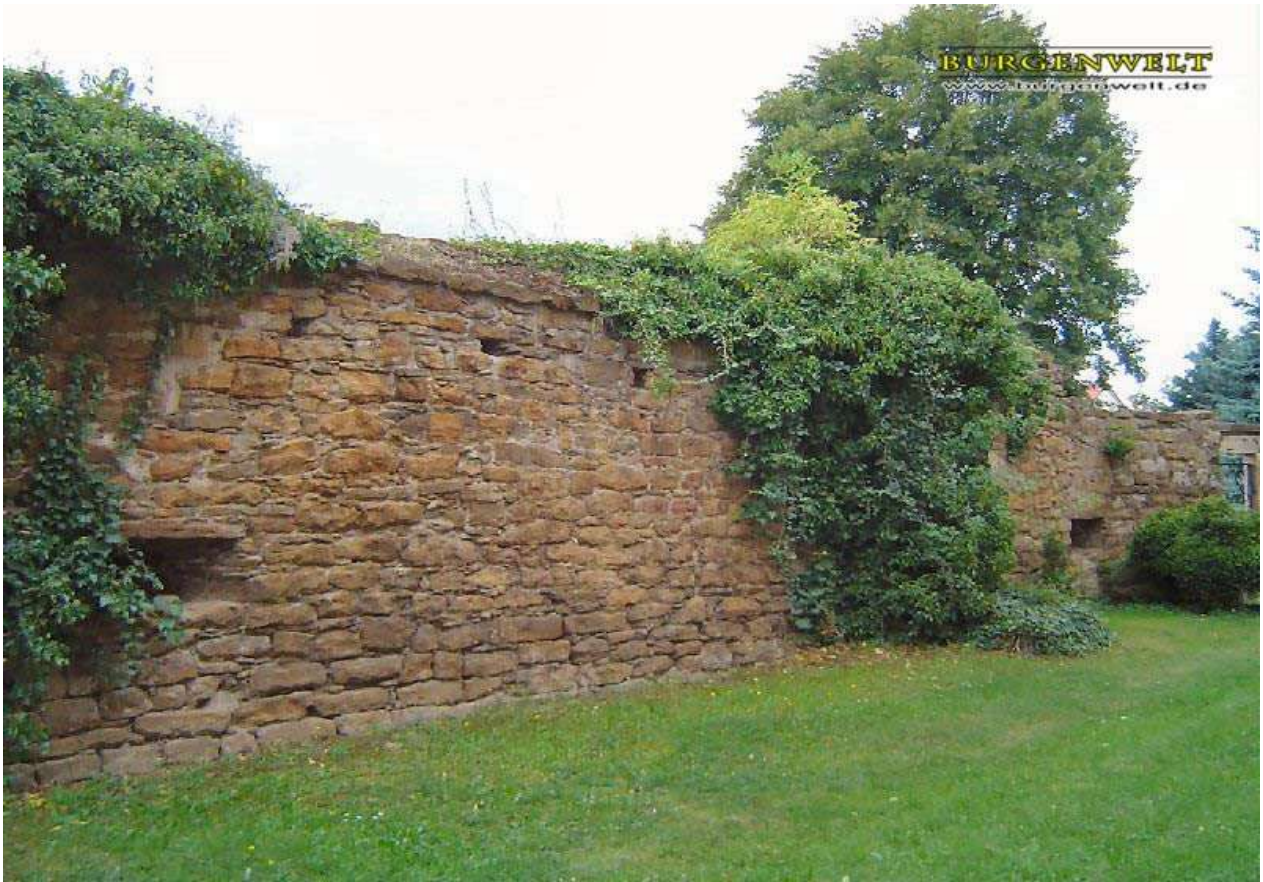
Abb. 10: Überrest der Wehrmauer mit Balkenlöchern des Wehrganges und Schießcharten
